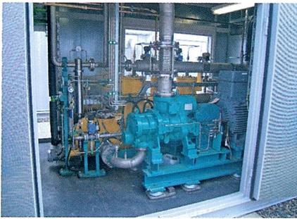
Für jede Anlagenkomponente – hier ein Gasverdichter (oben) und eine Aminwäschanlage (unten) – kann der Anlagenbetreiber mit der EX-RL-Beispielstabelle die Explosionsschutzmaßnahmen festlegen.
