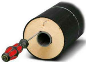
Mit dem Schraubendreher in den Schaumkern stechen und prüfen, ob sich im abzulängenden Bereich eine Pressmuffe befindet.
