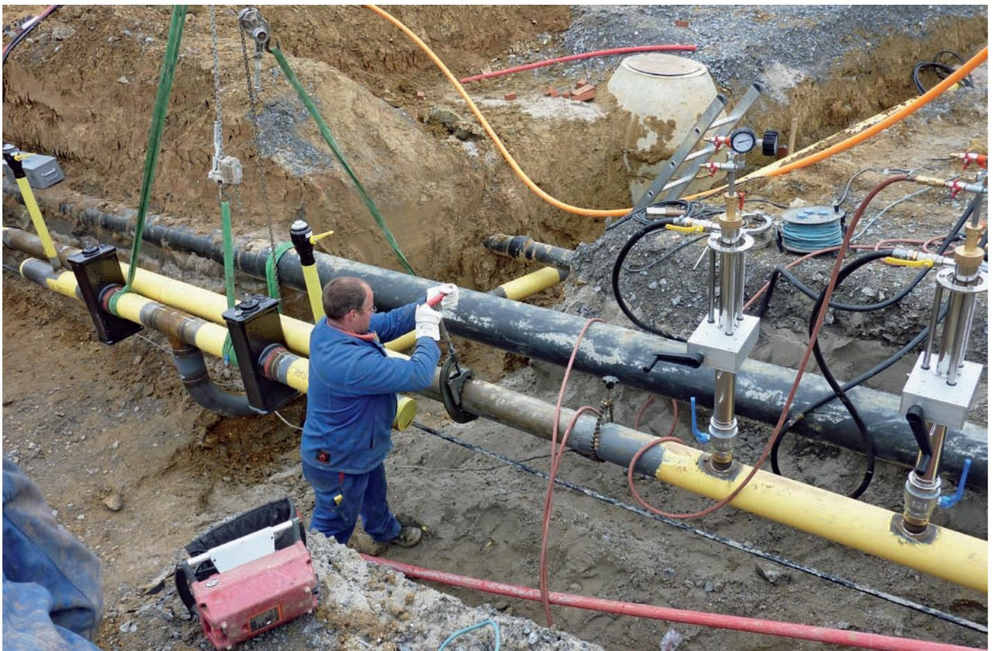
den. Einerseits wurden nach erfolgtem Druckausgleich die Druckblase und andererseits die Dunstblase gezogen. Es erfolgte das Befüllen des Arbeitsbereiches mit 3,2 bar über unsere Geräte mit Erdgas. Das Entlüften des Arbeitsbereiches erfolgte ebenfalls über die Blasenetzgeräte. Das Abseifen der Überschieber erbrachte ein dichtes Ergebnis. Es erfolgte das Ziehen der beiden letzten
