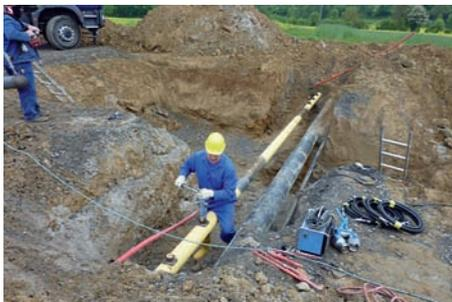
Als Rohrleitungsbauunternehmen war die Firma Martin Weitbrecht aus Stuttgart beauftragt. Zum Durchführen der Arbeiten wurde die bestehende Leitung zu zwei Seiten mit insgesamt 4 Geräten gesperrt. Über einen PE-Bypass Da 63 wurde die Versorgung aufrecht erhalten. Der Gasfluß in der zu sperrenden Leitung war gering.
