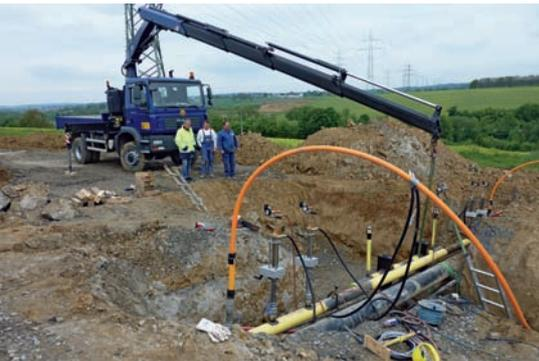
Blasen. Die Stopfen wurden mittels Schleuse in die Aufschweißmuffen gesetzt.
